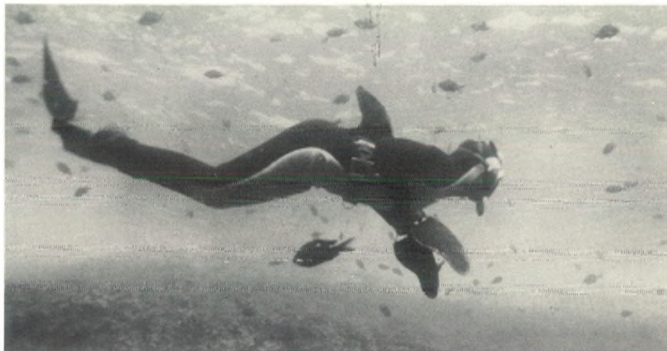
Afb. 3 Een speciaal duikpak, vervaardigd door de Nieuwzeelandse firma Moray Industries, wordt door de duikster Jan Doak gedragen bij de studie van dolfijnen in de wateren rond Nieuw-Zeeland, genaamd Project Interlock. De benen zijn met elkaar verbonden om zo de staartvin van een dolfijn na te bootsen. De buik is wit en de rug is zwart gekleurd. Foto Michael Donoghue.
